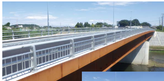
完成した橋(開通前)
