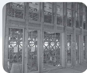
▲建設中の議場の入口
